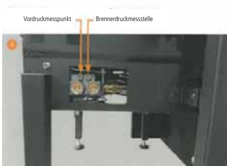
Abb. 2.8 Messstelle für Vordruck / Brennerdruck
