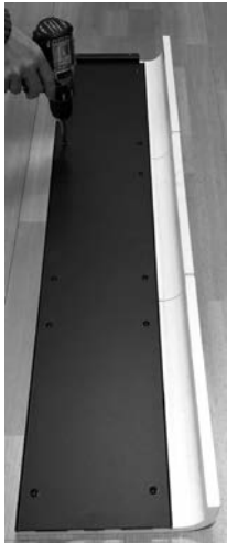
Fig. 35 - Verlegen der Majoliken
