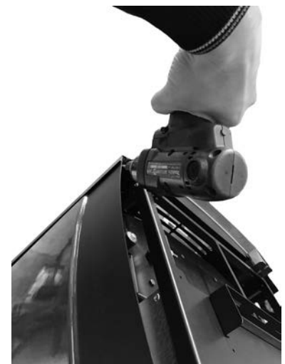
Fig. 56 - Den Ausgleich befestigen
