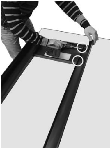
Fig. 22 - Befestigung des Trägers
