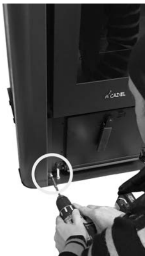
Fig. 25 - Befestigung des Rahmens
