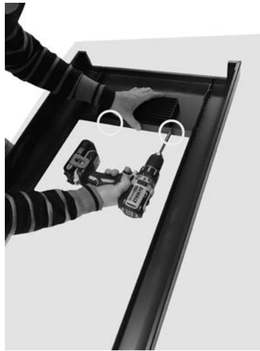
Fig. 23 - Befestigung des Gitters
