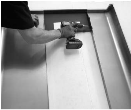
Fig. 42 - Befestigung des Trägers
