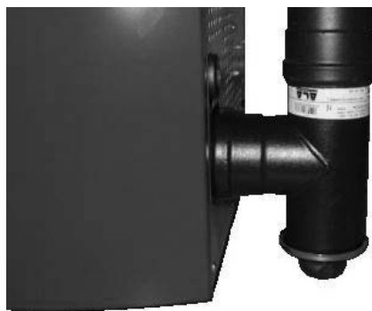
Fig. 86 - Reinigung des Rauchgaskanals
