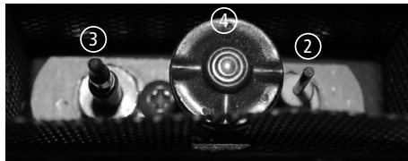
Abb. 5.1 Flammenwächter, Pilot-Brennerdüse und Zünddorn
