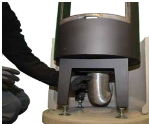
16. Die Verbrennungsluft zuführung (Flexschlauch Ø 125 mm) mit Schnellspannschelle am unteren Stützen montieren.
