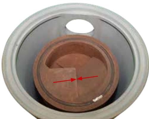
46. Fünften Schamottering auflegen und Drehzugrichtung durch Verdrehen einstellen.
