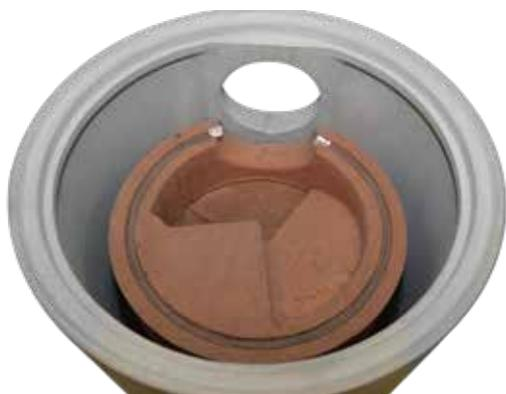
35. Fünften Schamottering mit Anschlussbohrung auflegen und Drehzugrichtung durch Verdrehen einstellen.
