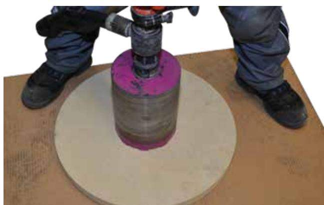
54. Bohrposition auf der Innen-Deckenplatte (Vermiculite) anzeichnen und ebenfalls für 160 ´er Anschluss bohren.
