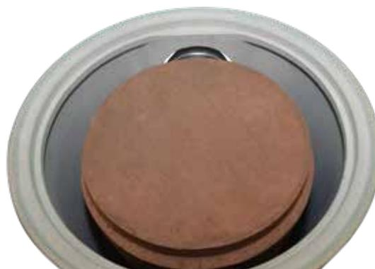
38. Abschluss Schamottering mit Anschlussbohrung auflegen.
