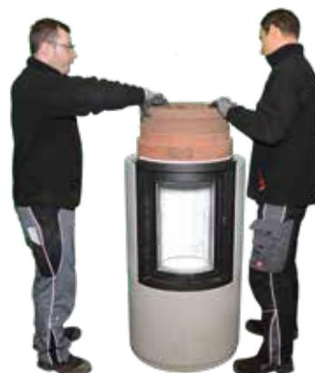
28. Den ersten Schamottering setzen. Die Montagehilfslinie am Schamottering genau zur Montagehilfslinie am unteren Schamottering ausrichten. (Nur bei Wandanschluss).
