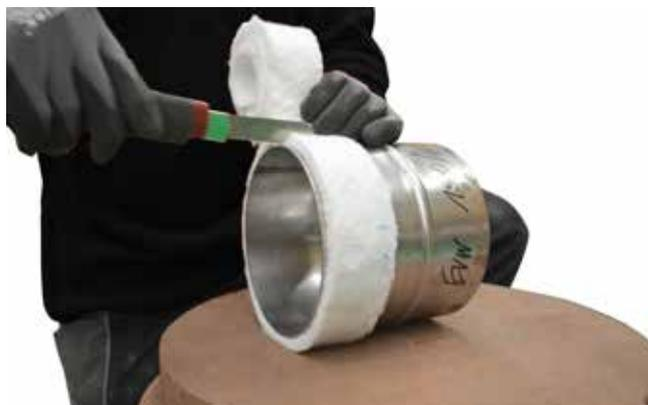
36. Rohrerweiterung vorbereiten. Bitte das Dichtungsvlies um den  $\varnothing 150$  mm wickeln und passend schneiden.
