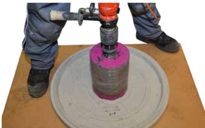
53. Anschlussposition zur Decke (auf der Unterseite der Deckenplatte vorgegeben) für 160 ´er Anschluss bohren.
