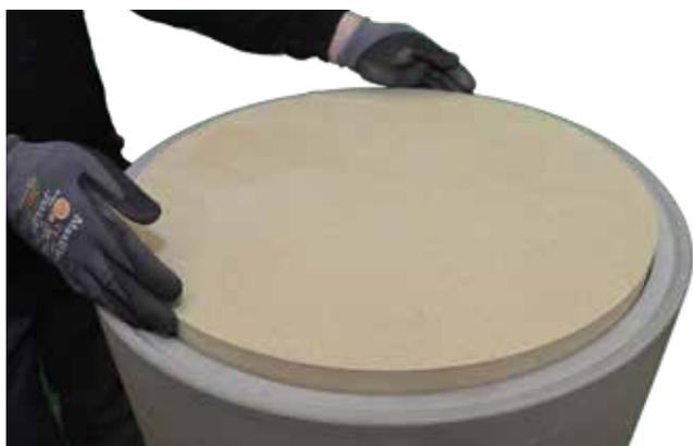
44. Alle Teile mit Acrylkleber neu setzen und die Innen Deckenplatte (40 mm Vermiculite) von oben in das Haubenteil einlegen.
