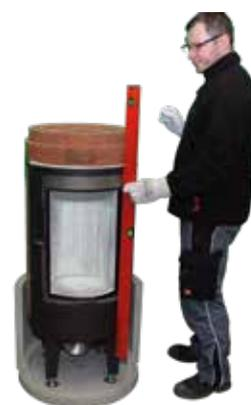
20. Grundofenkorpus mit Wasserwaage ausrichten und ggf. nachstellen.
