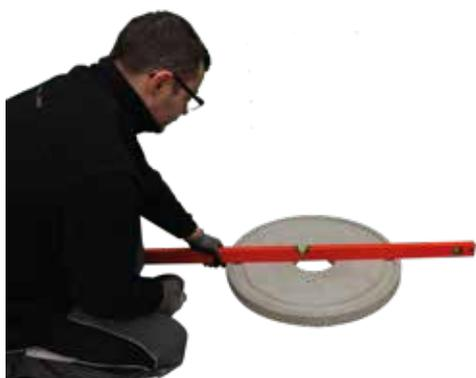
1. Bodenplatte an gewünschter Position auf dem Fußboden ausrichten.
