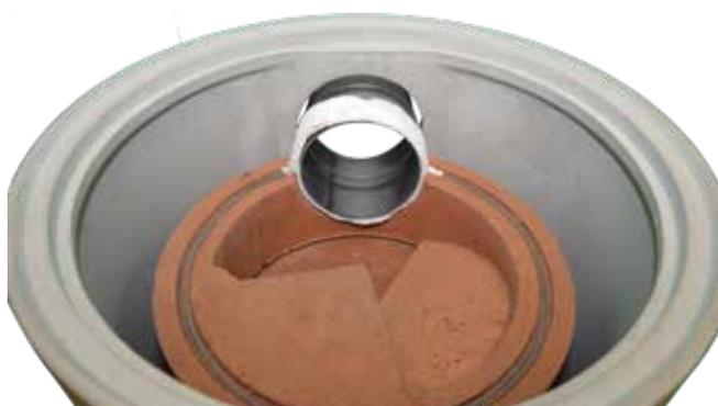
37. Rohrerweiterung  $\varnothing 150$  mm auf  $\varnothing 160$  mm jetzt mit dem Dichtungsvlies in die Anschlussbohrung setzen.
