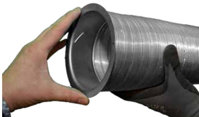
50. Einbaurahmen in den Aluflexschlauch Ø 125 mm drücken...
