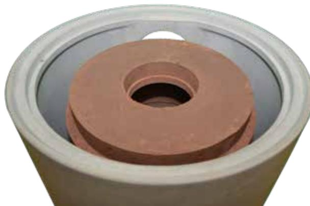
47. Abschluss-Schamottering mit Anschluss zur Decke auflegen.
