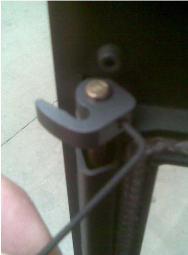
**Unteren Schließhaken mittels eines 2 mm Inbuss-Schlüssels lösen.**
