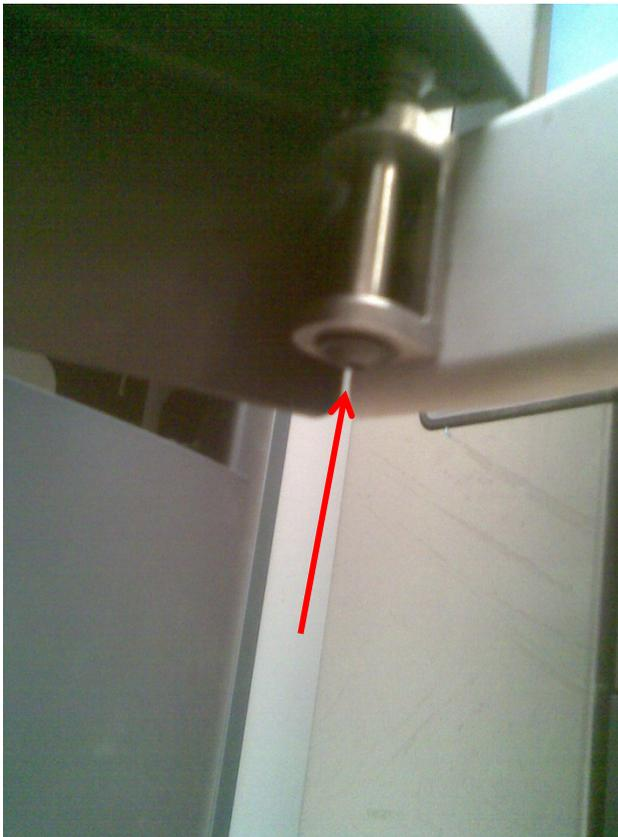
Den unteren Schließhaken lösen, nicht den oberen. Auf Feder und Scheibe aufpassen! Den Querstift in der Achse entfernen. Die Achse kann jetzt nach oben gehoben werden.
