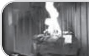
7. Теперь щепки быстро разгораются и верхние, более тонкие занимаются светлым пламенем. Теперь следует полностью закрыть дверцу топочного элемента.
