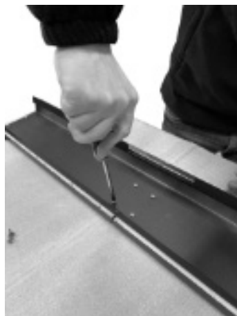
Fig. 40 - Verlegen der Majoliken
