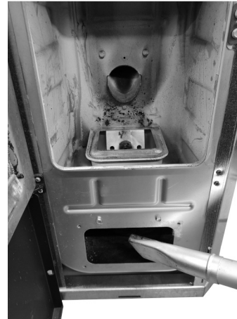
Fig. 71 - Die Asche absaugen
