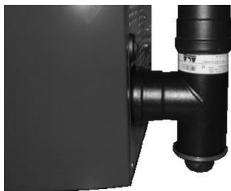
Fig. 64 - Reinigung des Rauchgaskanals
