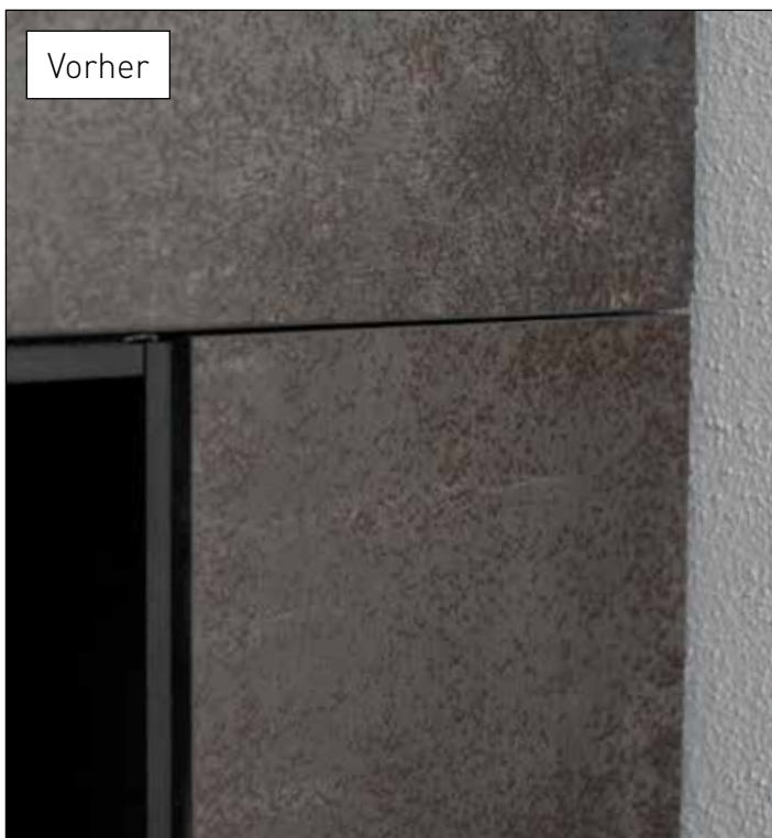
Ausrichten der Verkleidung
