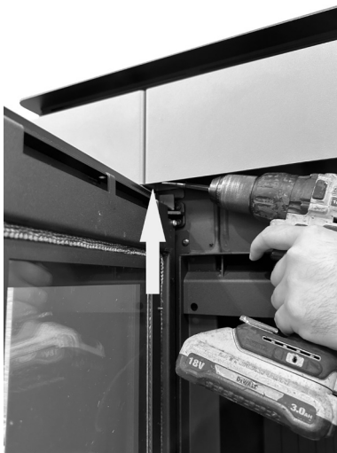
Fig. 21 - Entfernen Sie die Sicherheitsschraube
