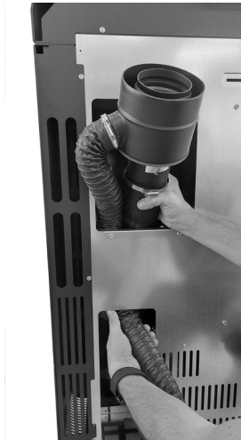
Fig. 35 - Rohr Durchm. 80 mm einstecken
