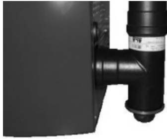
Fig. 63 - Reinigung des Rauchgaskanals
