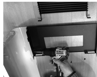
Fig. 28 - Die Platte an der Strebe befestigen
