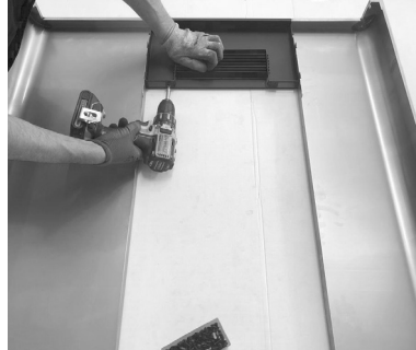
Fig. 38 - Befestigung des Gitters
