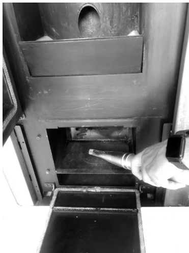
Fig. 83 - Die Asche absaugen
