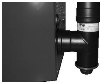
Fig. 75 - Reinigung des Rauchgaskanals
