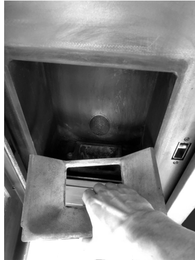
Fig. 81 - Die Asche absaugen
