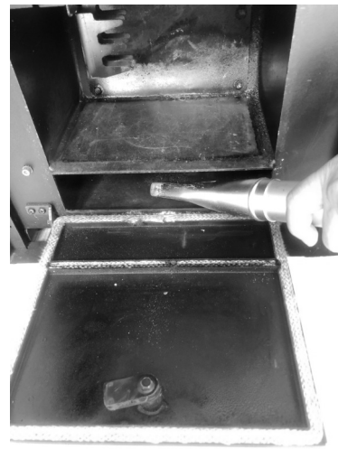
Fig. 84 - Die Asche absaugen
