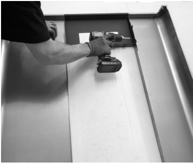
Fig. 37 - Befestigung des Trägers
