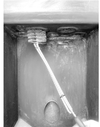
Fig. 82 - Mit einer Rohrreinigungsbürste reinigen
