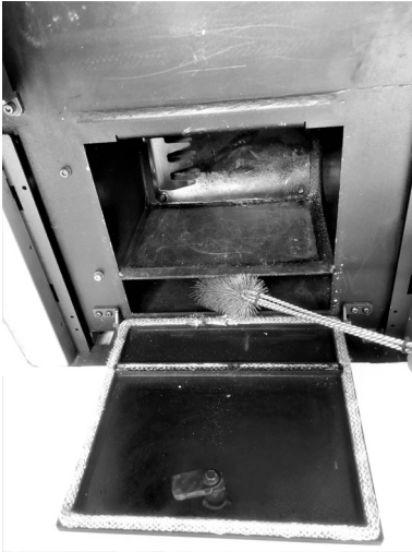
Fig. 80 - Mit einer Rohrreinigungsbürste reinigen
