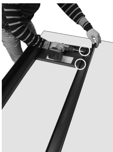
Fig. 20 - Befestigung des Trägers
