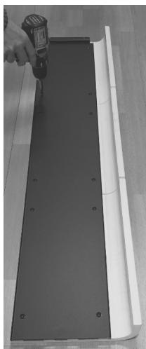
Fig. 33 - Verlegen der Majoliken
