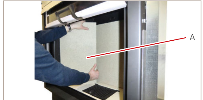
Abb. 31: seitliche Innenauskleidung entnehmen
