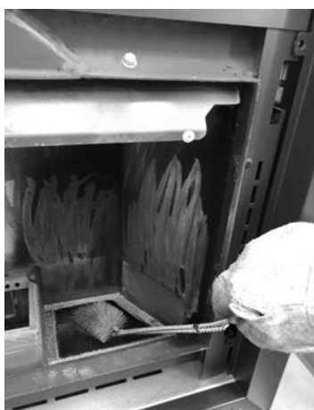
Fig. 100 - Mit einer Rohrreinigungsbürste reinigen
