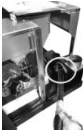
Fig. 111 - Reinigung des Rauchgaskanals
