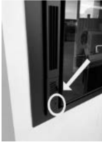
Fig. 25 - Thermostatsonde
