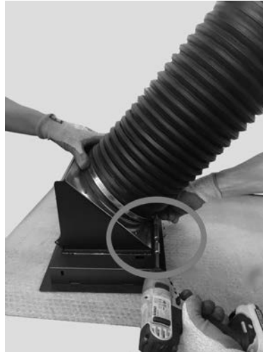
Fig. 59 - Schellen festziehen
