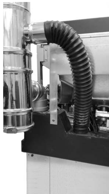
Fig. 75 - Anschluss der Verbrennungsluftleitung
