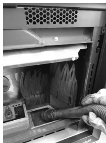
Fig. 101 - Die Asche absaugen
