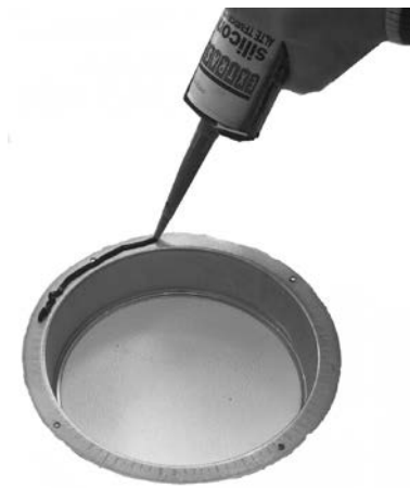
Fig. 62 - Silikon den Flansch
