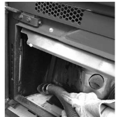
Fig. 104 - Die Asche absaugen
