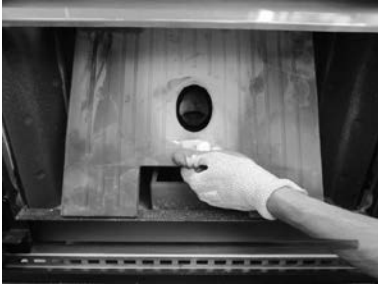
Fig. 108 - Entfernung der mittleren Wand aus Gusseisen
