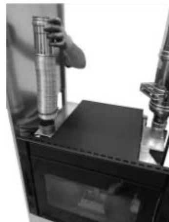
Fig. 57 - Einsetzen des Einsatzes
